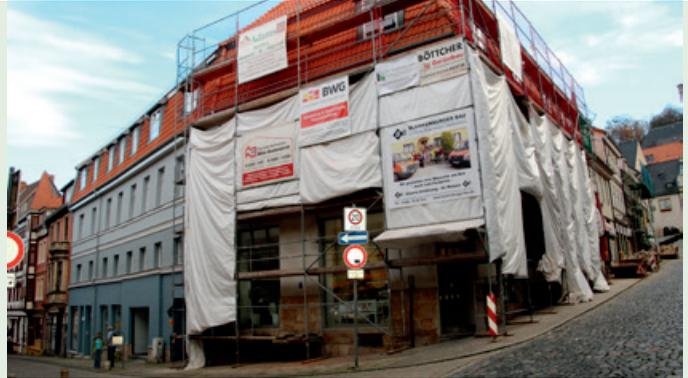
Die Sanierung und Modernisierung der Tränkestraße 21 schreitet voran. Das Dach ist neu gedeckt und hinter den Planen des Baugerüsts entsteht eine neue Fassade mit Innendämmung. Innerhalb des zweiten Bauabschnittes erfolgen unter anderem der Einbau wärmeschutzverglaster Fenster, die Dämmung der obersten Geschossdecke, eine außengeämmte Fassade auf der Hofseite sowie die Neuinstallation von Heizung, Wasser, Sanitär und Elektro.
