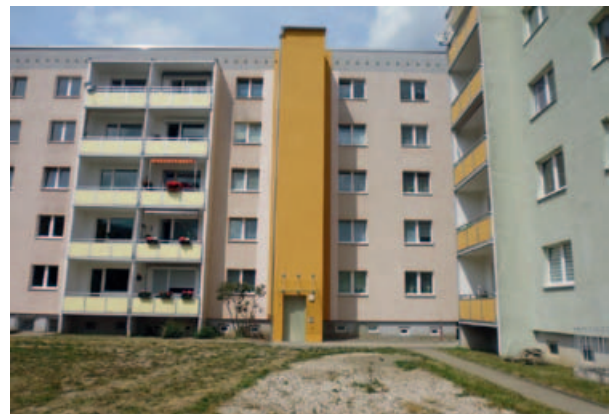
In der Käthe-Kollwitz-Straße 21 wurde ein Personenaufzug angebaut.
