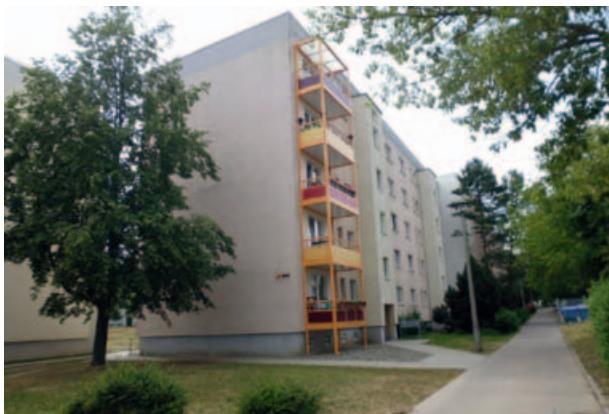
Umfangreiche Sanierungs- und Modernisierungsmaßnahmen verbesserten das Wohnen in der Käthe-Kollwitz-Straße 21.
